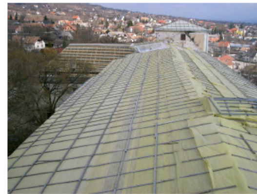
Zichy kastély Zsámbék 1800m 2 tetőszerkezet felújítása és természetes palafedés
