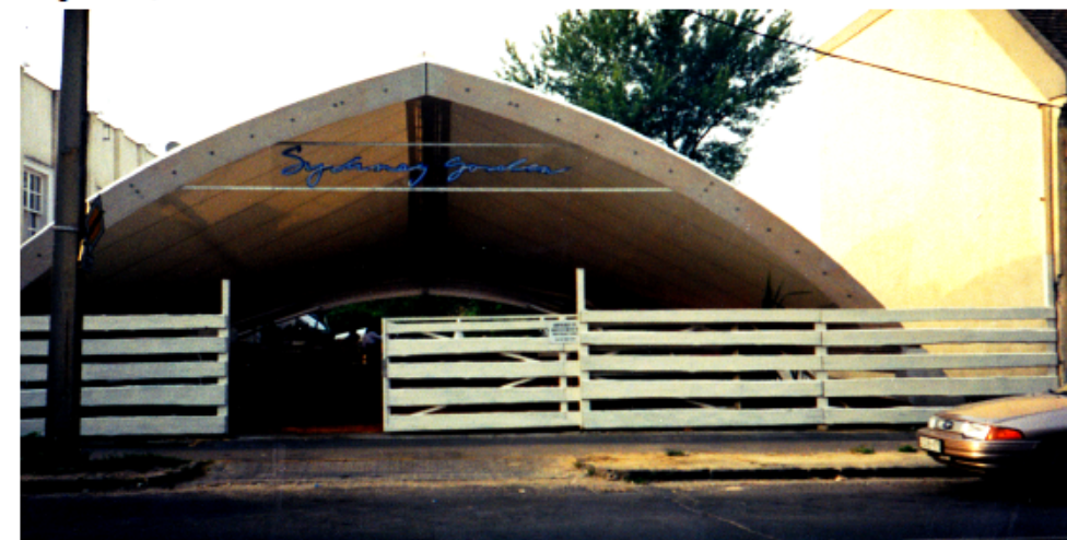
Sidney Garden étterem Budapest, Csillaghegy Ragasztott, íves fatartószerkezet kivitelezése
