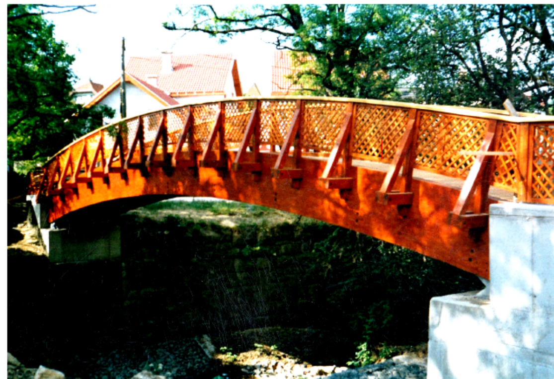
Máriaremete - Paprikás-patak Patak feletti gyalogos hid Szerkezeti kivitelezés
