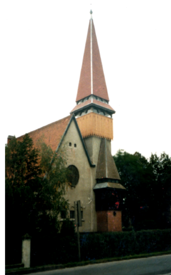
Mosonmagyaróvári Református templom Teljes toronyszerkezet rekonstrukció
