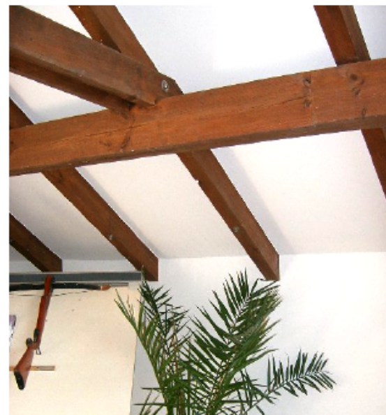
A beltérben látványosak az íves ragasztott tartók és látszó tetőszerkezet. A többszintes gerendavázás épületeink jellemzője, hogy a földszinten a fafödém láthatóan megjelenik. A tartószerkezet szintén ragasztott kivitelben készült amely évek múltán is repedésmentességet biztosít.
