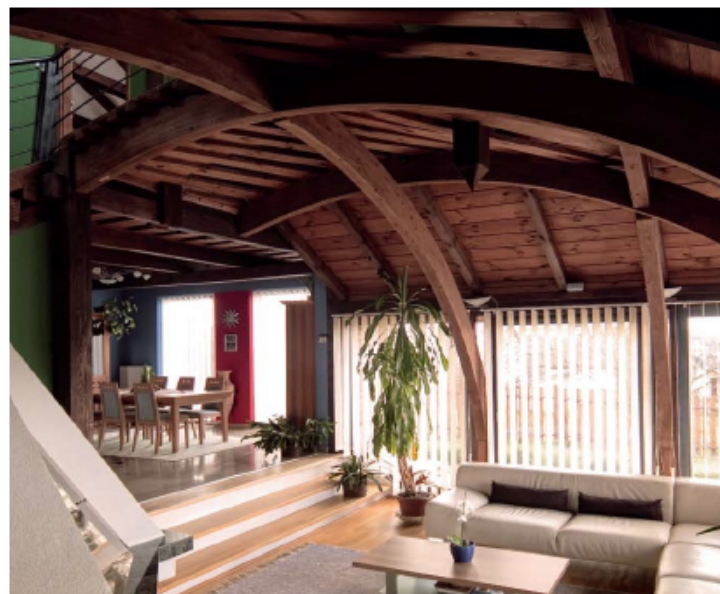
A beltérben látványosak az íves ragasztott tartók és látszó tetőszerkezet. A többszintes gerendavázás épületeink jellemzője, hogy a földszinten a fafödém láthatóan megjelenik. A tartószerkezet szintén ragasztott kivitelben készült amely évek múltán is repedésmentességet biztosít.
